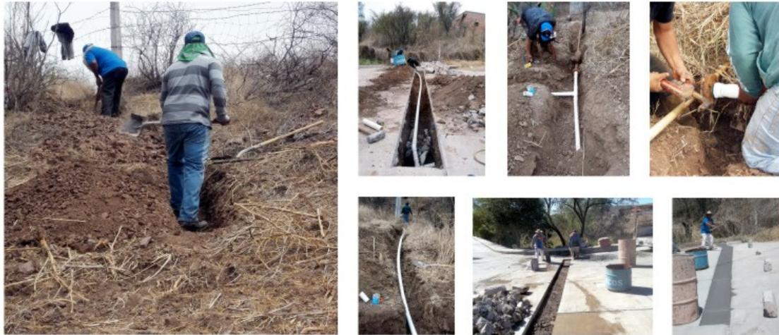
**Se realizó la excavación de una zanja de 300 mts. lineales en La Labor de la Concepción.**
